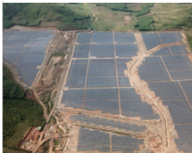
越南芽庄金兰 100MW 地面光伏电站
