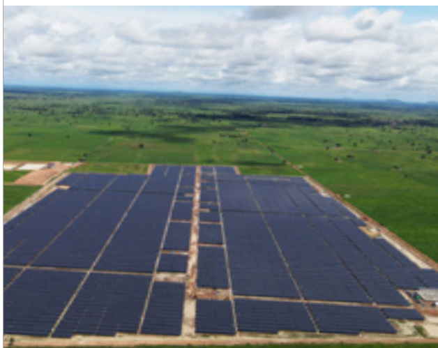
柬埔寨班迭棉吉省 39MW 地面光伏电站
